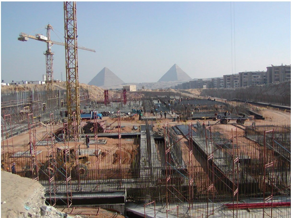
図7 ギザのピラミッドが見えるGEM工事現場 (JICA提供)
